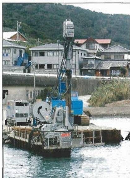
硬質地盤クリア工法
