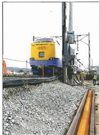
硬質地盤クリア工法
